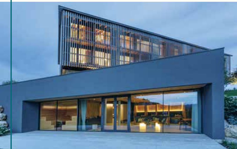
Verdrehter Unterbau: Auf der Rückseite des Naturhotels ragt der Wellnessbereich mit Sauna und Ruheraum aus dem Hang.
